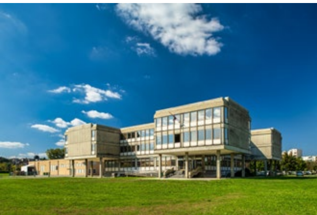
Zgrada Državnog arhiva u Karlovcu prije početka preseljenja i cjelovite obnove, listopad 2025. Foto: Denis Stošić
